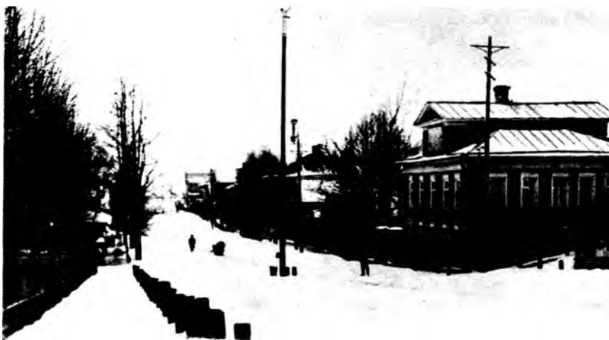
Въезд в Кологрив по улице Романовской
