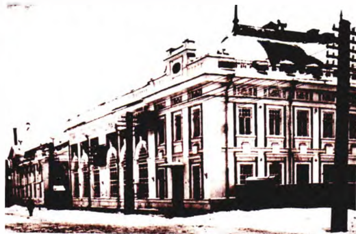
Здание Костромской городской электростанции. Фото 1928 г.
